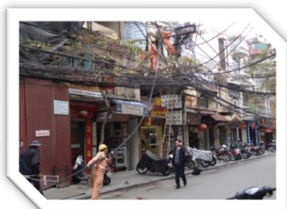
Un ouvrier réparant un réseau électrique à Hanoi
